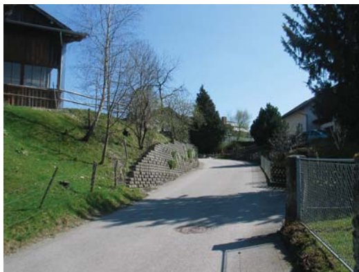
Stützmauer in Eglham
