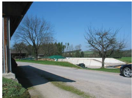
Zu verlegende Dorfstraße im Norden
