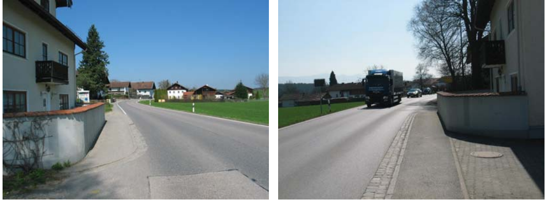
Seitenbereiche in Aign an der Staatsstraße
